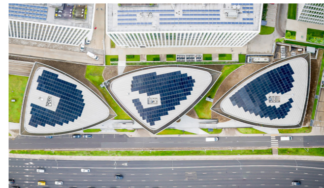
ROOF-SOLAR PVC / 302,4 kWc Lituanie
